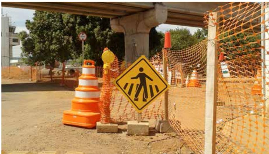
Figura 3: Placa, passagem sinalizada de pedestres, instalada de maneira improvisada no contorno que dá acesso ao aeroporto Marechal Rondon. Elaboração própria (8 de agosto de 2013).
