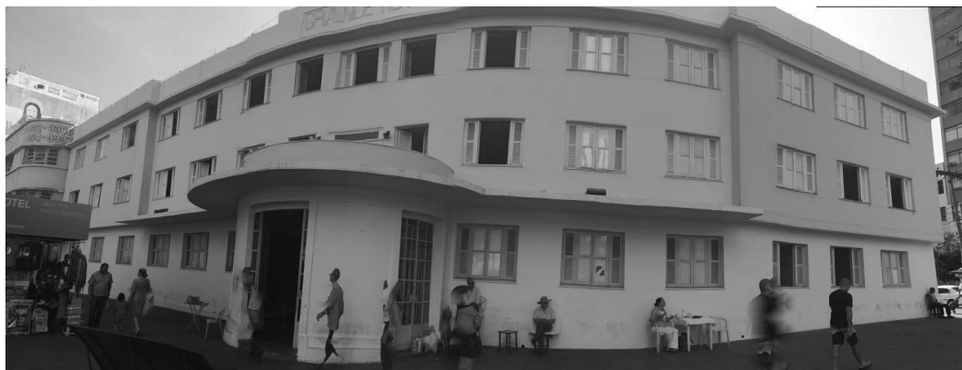
Figura 1: Fotografia Panorâmica da Fachada do Grande Hotel Fonte: Thais Oliveira (2017).
