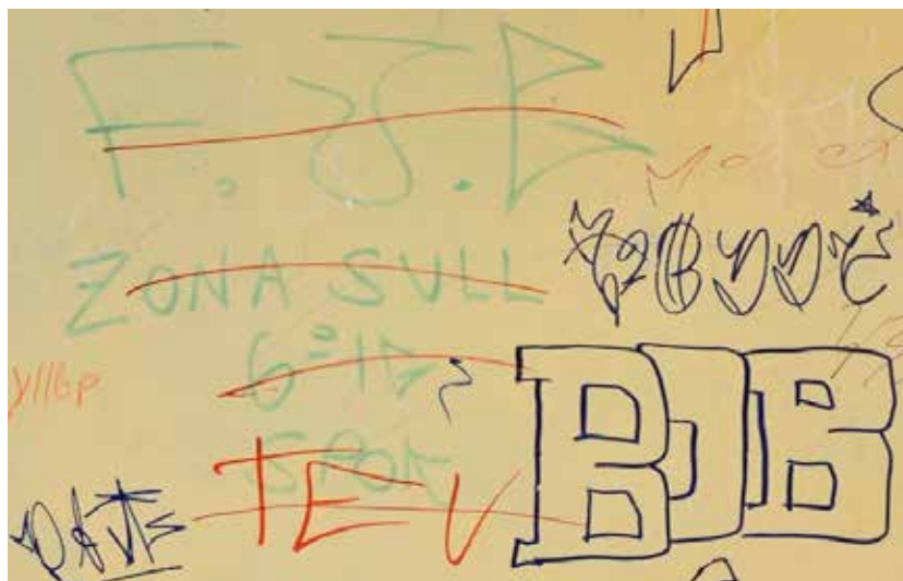
Figura 1 Sala de aula. Pichações sobre parede. Foto: Paul Moraes 2011.
